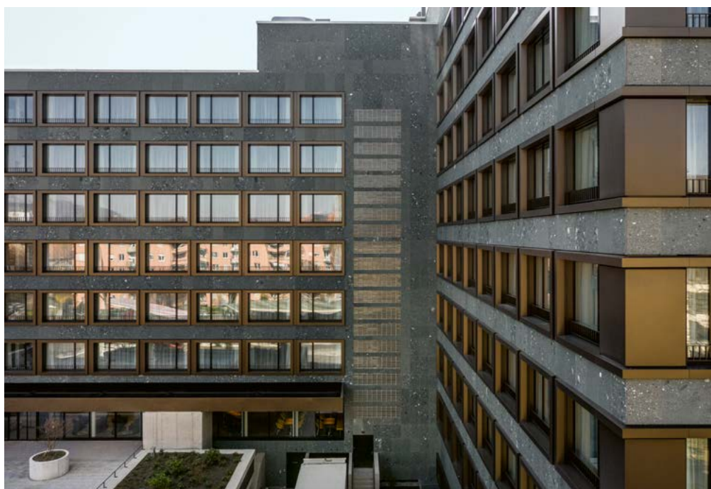
Die neue Gebäudehülle gibt dem Bau ein völlig anderes Gesicht.
