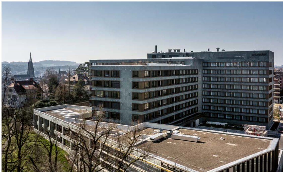
Baukörper nach der Umnutzung.
